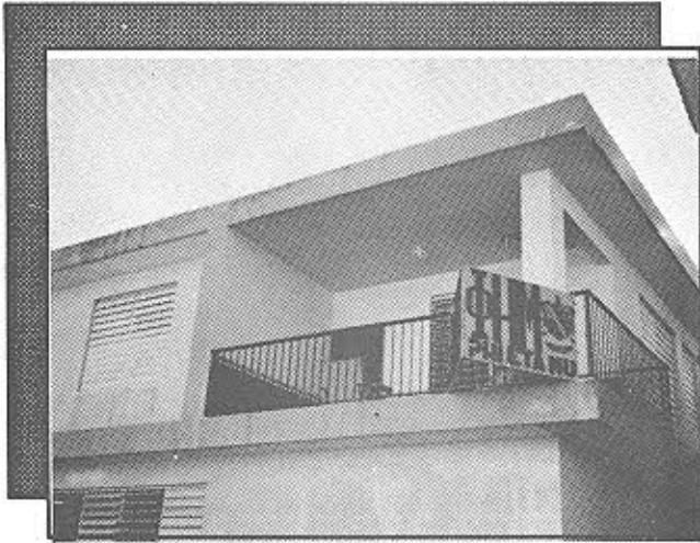
La Casita , Calle Concepción.
